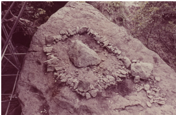
写真8 復元検討段階（北から）（1970/5/21）
