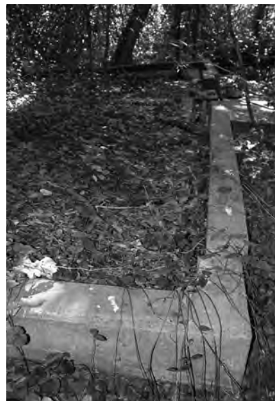
写真5 防備衛所(建物基礎)
