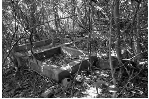
写真9 海軍施設(建物基礎)
