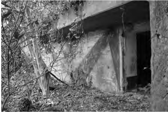
写真 11 西上弾薬庫外観
