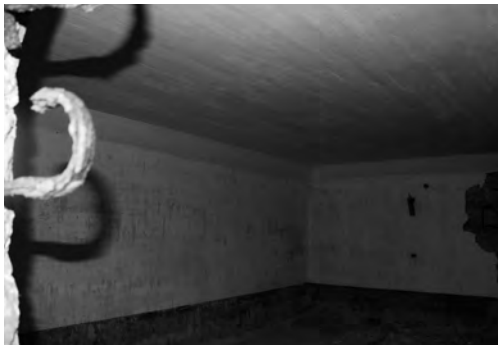
写真20 東側弾薬庫内部
