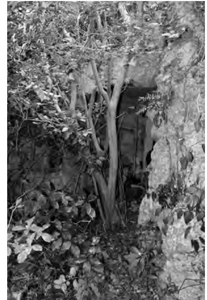
写真 21 東側弾薬庫入口
