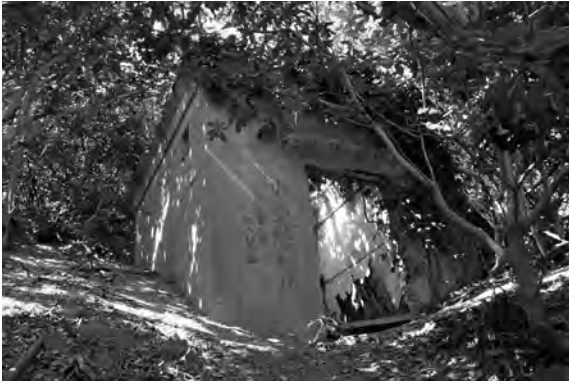
写真1 土石採取に関連する施設
